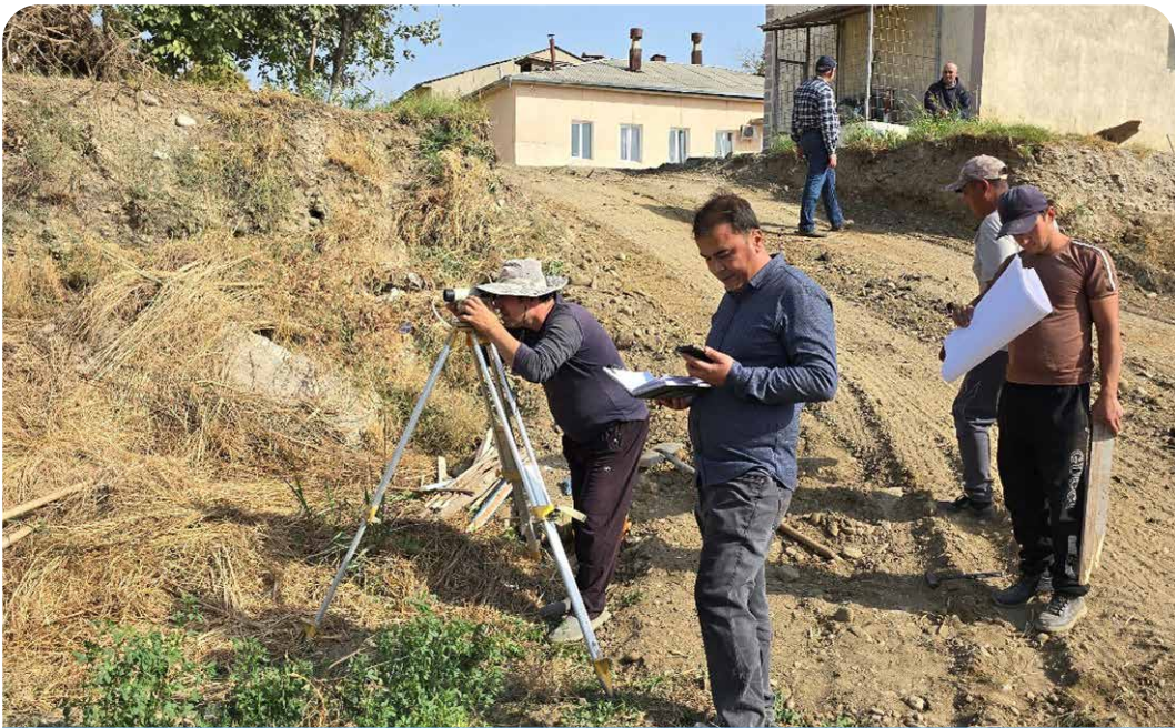
Site de construction d'infrastructures de traitement biologique de l'hôpital Dehmoy, Tadjikistan
